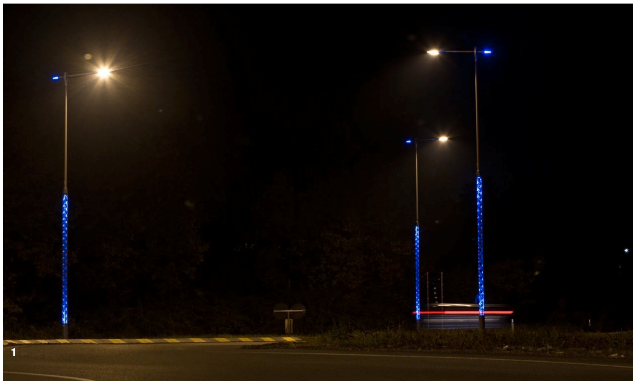
1. Pali a sicurezza passiva installati dalla Provincia di Bergamo
